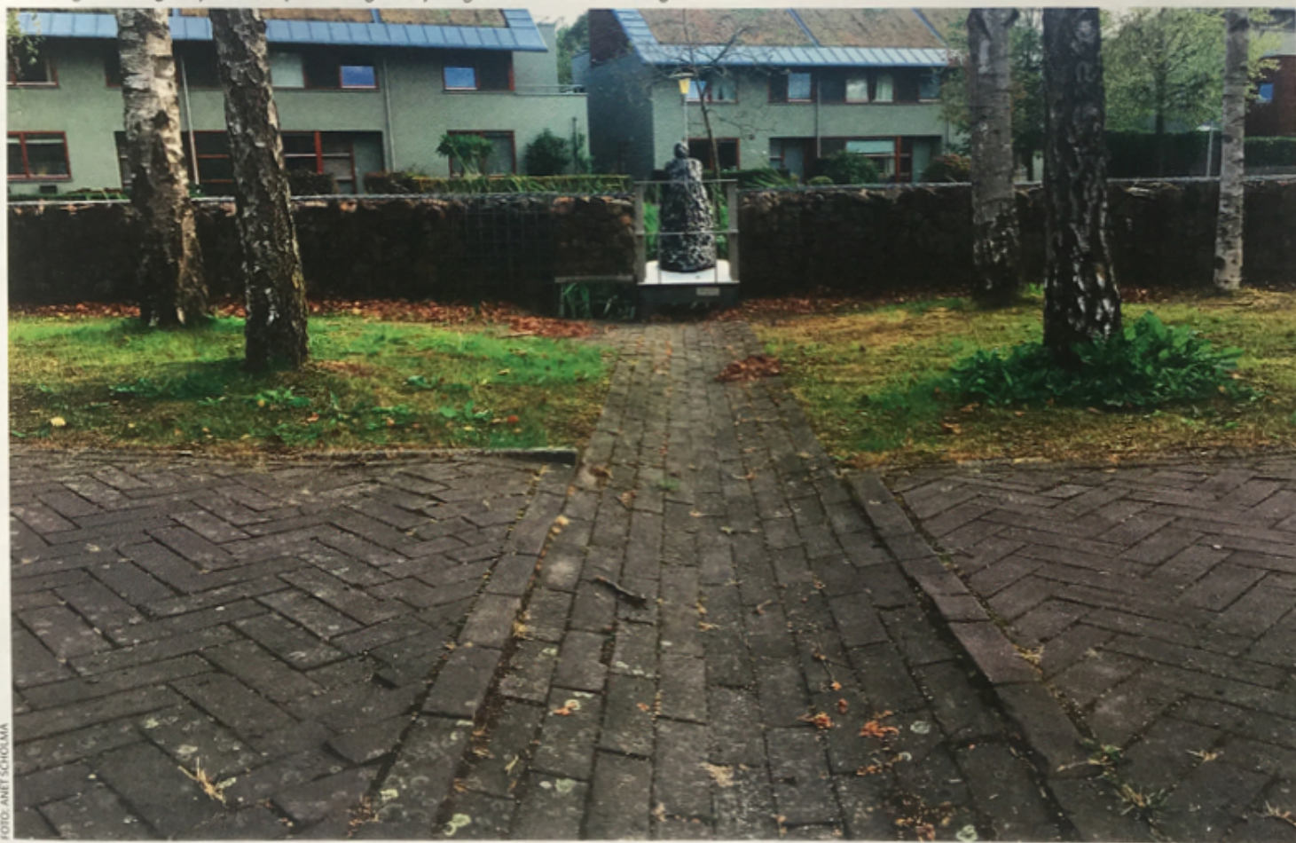
De watergoten eindigen bij de wadi. Op de achtergrond zijn de groene daken van de woningen zichtbaar
